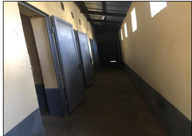
Couloir après les travaux
