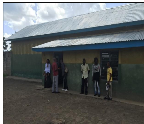
Façade extérieure après les travaux
