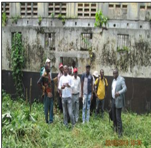
Façade extérieure du bâtiment avant les travaux
