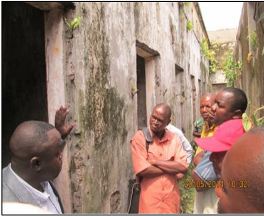
Couloir menant aux cellules avant les travaux
